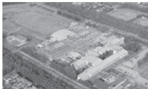
建設が進む大潟小・中学校校舎（自ら操縦するセスナ機から撮影）
