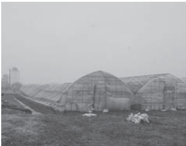
暴風により被害を受けたハウス
