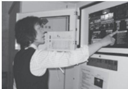
発電機稼働訓練
