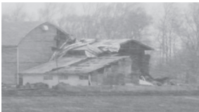
農舎の屋根・壁・シャッターが損壊
