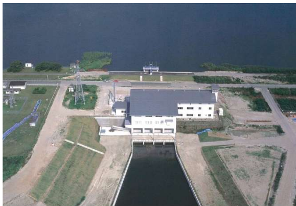
北部排水機場
