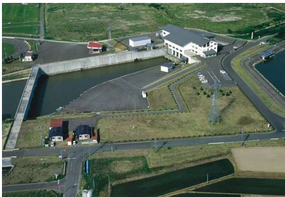
南部排水機場
