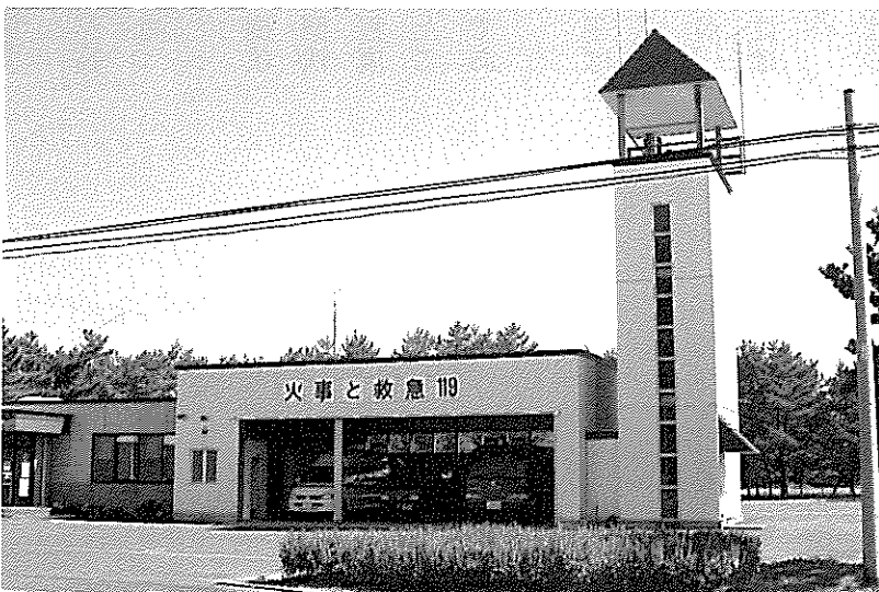
村の防災拠点である男鹿地区消防署大潟分署。
