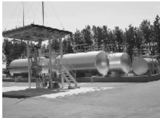
完成した工場。大きなタンクが並んでいます。
