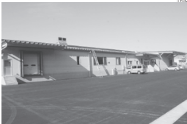
完成した（株）餃子計画の工場。
