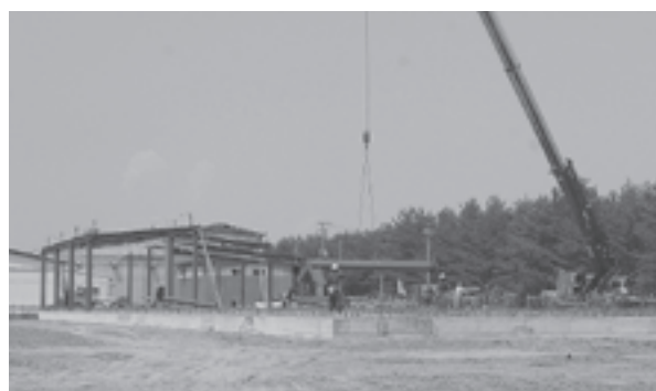
建設中の（株）餃子計画の工場。
