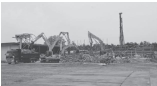
解体工事中の小・中学校旧体育館。
