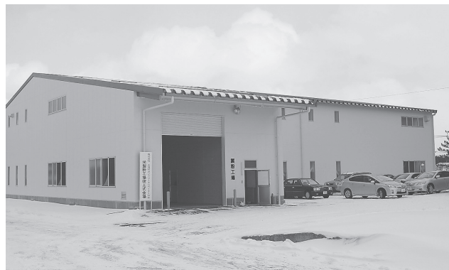
完成したカントリー公社の米粉製粉工場。
