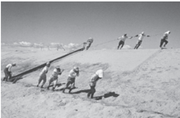
干拓堤防工事の様子
