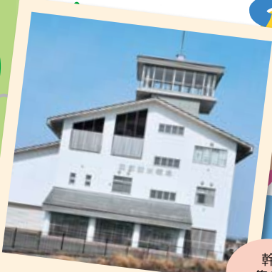
南部排水機場
