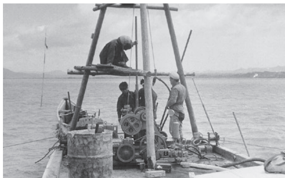
ボーリング調査
