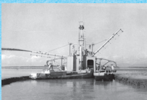
▲排水路掘削に活躍した特殊小型浚渫船
