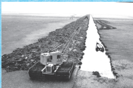
▲小排水路の掘削に活躍するマーシクラムシェル
