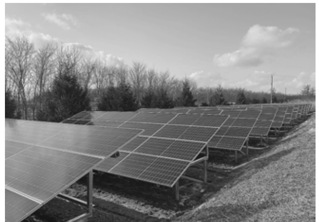
※ホテルサンルーラル大潟西側に建設中の太陽光パネル（約849kW…サンルーラルの電気使用量の約1/2をカバーできる計算）
