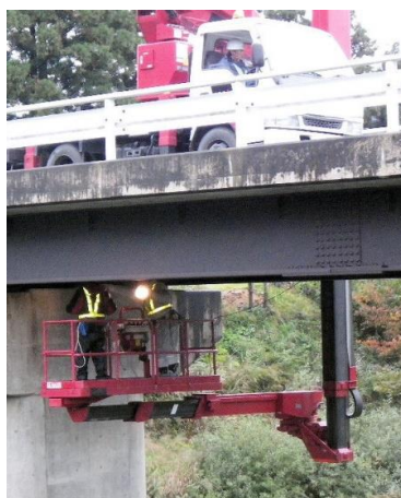
写真3.3 点検車による点検
