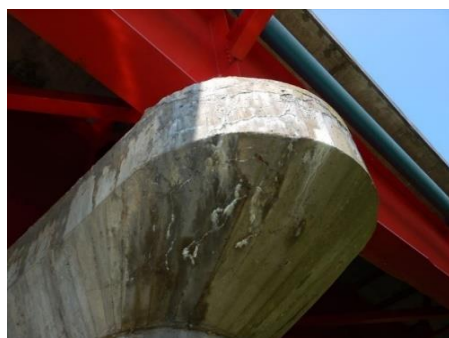
橋脚の遊離石灰を伴うひびわれ
