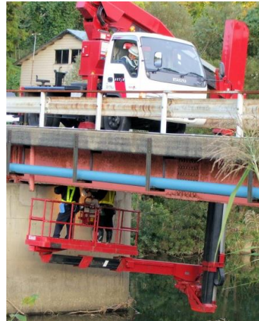
写真3.3 点検車による点検
