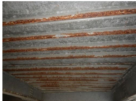
鋼床版の腐食
