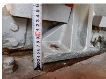
支承のボルトの脱落・傾斜
