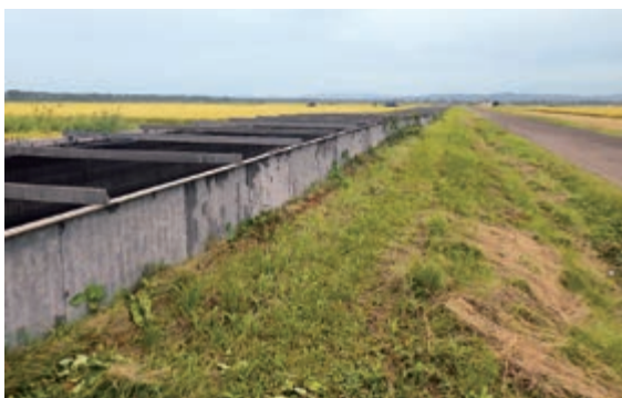
幹線用水路の不同沈下状況
