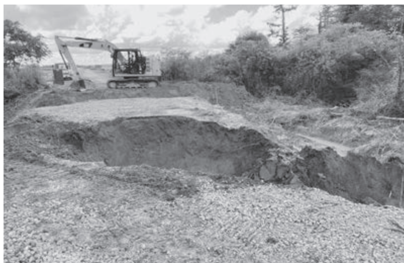
8月の豪雨により西5丁目村道が陥没
