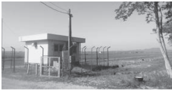
村民生活に欠かせない水道水の安定供給を(水源地ポンプ場)
