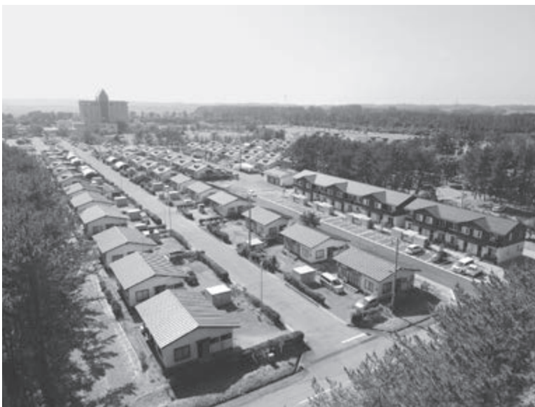
脱炭素先行地域事業では村営住宅の更新時に太陽光発電と蓄電池を設置予定
