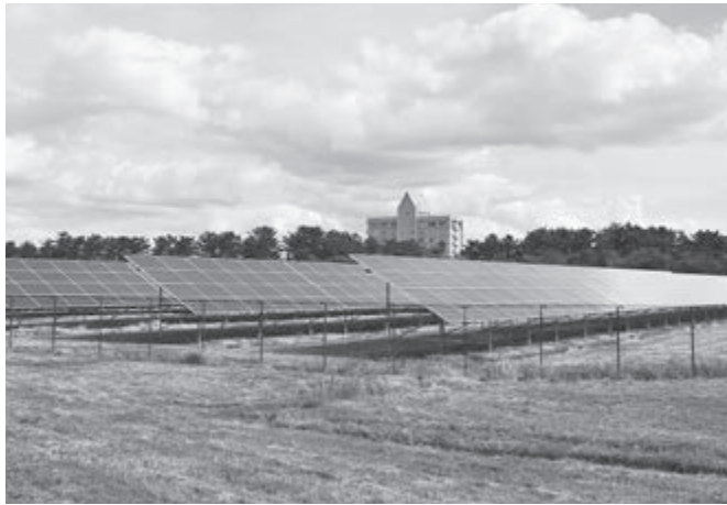
村が出資している大湯共生自然エネルギー発電所
