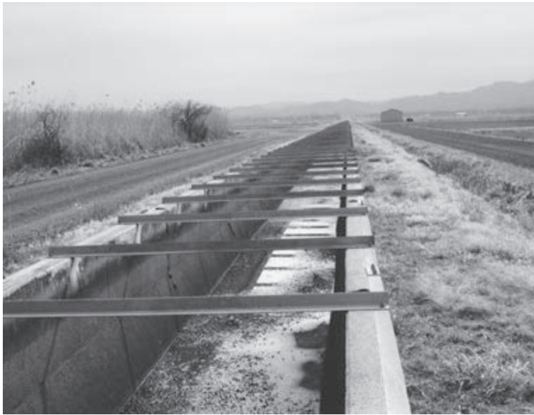
令和3年度から改修予定の幹線用水路
