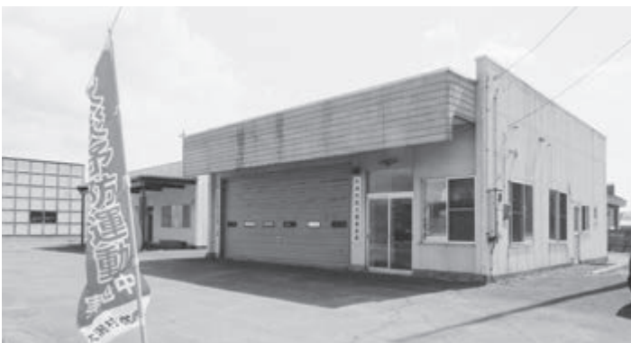
改築予定の防災センター
