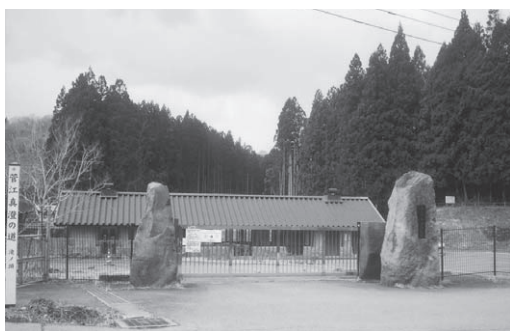
男鹿市五里合の浄水場
