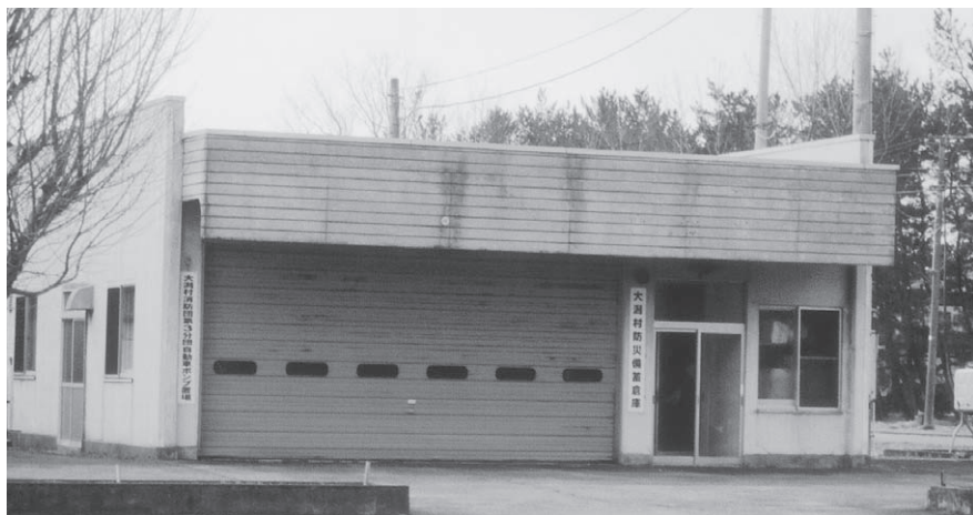
備蓄倉庫の整備が急務
