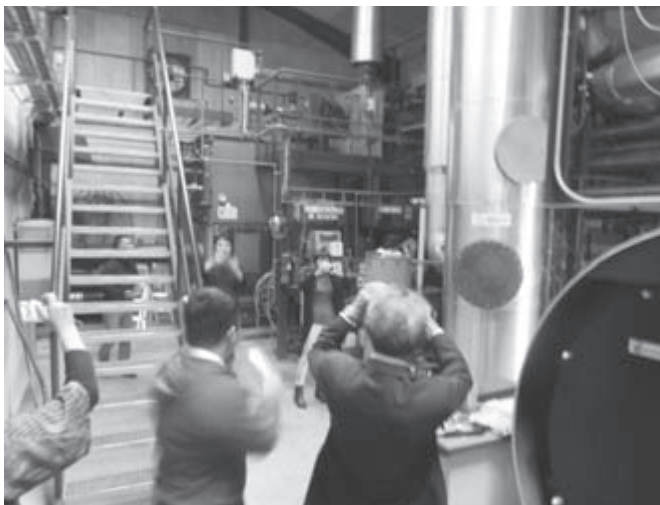
バイオマスボイラー（デンマーク）
