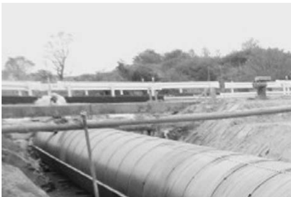
西野橋改修工事
