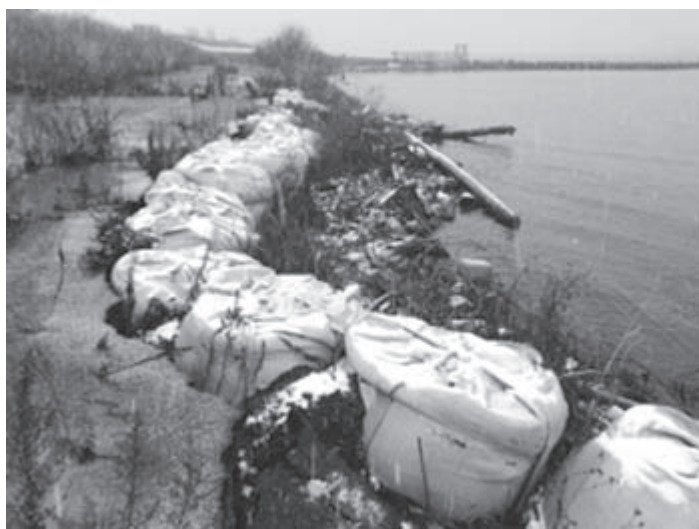
浸食した正面堤防
