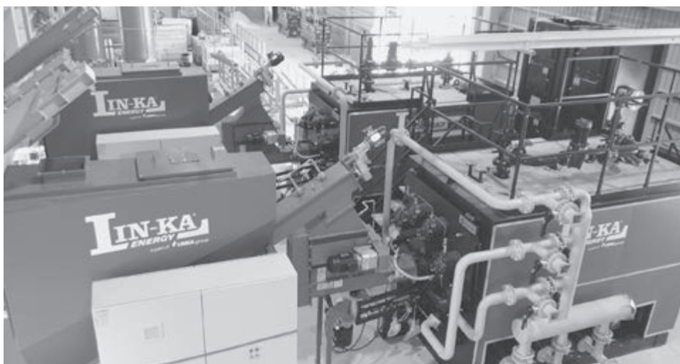
ボイラー設置も完了し本格稼働へ
