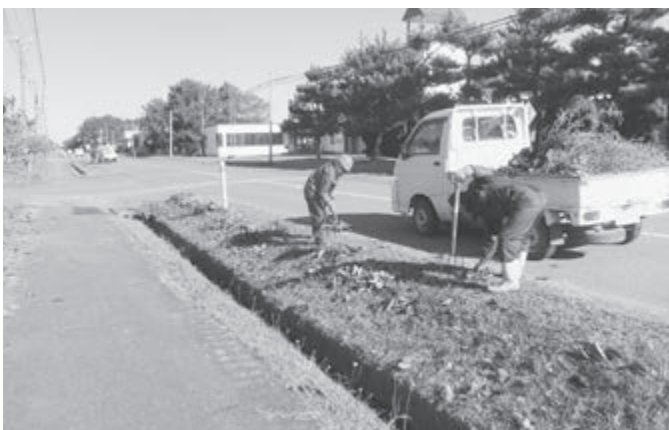
シルバーによる側溝の泥上げ
