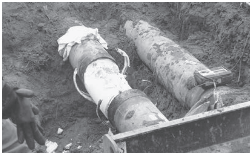
熱導管の修理状況
