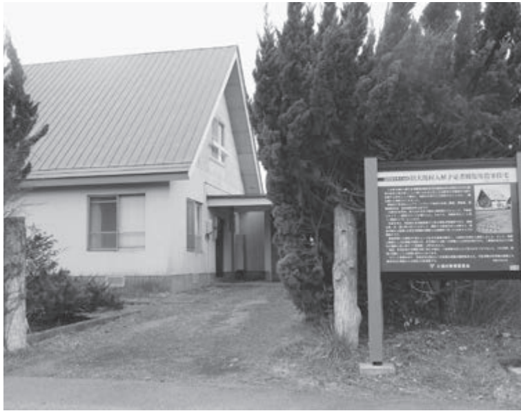
多目的会館東分館として活用される 国の登録有形文化財の三角屋根住宅
