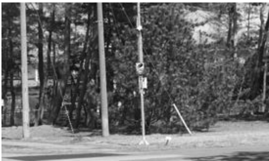
村内に設置されている防犯カメラ
