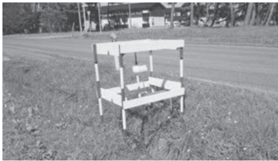
大雨時の側溝排水能力の調査
