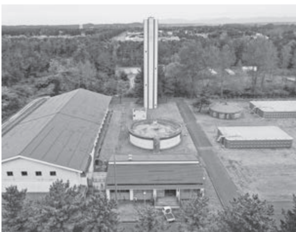
浄水場のシステム改修で職員の負担軽減に
