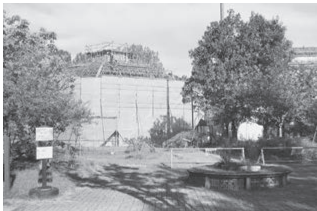
県による修繕工事がすすむ生態系公園温室
