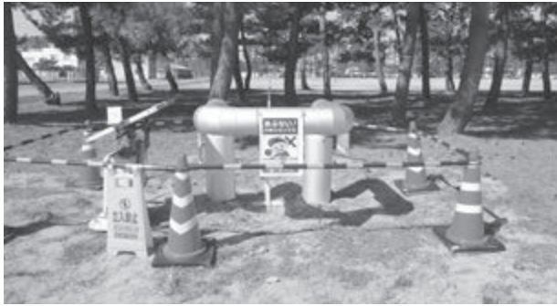
修繕された熱導管
