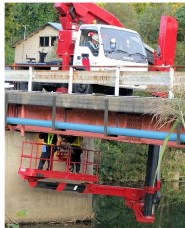
写真3.3 点検車による点検
