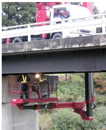
写真3.3 点検車による点検
