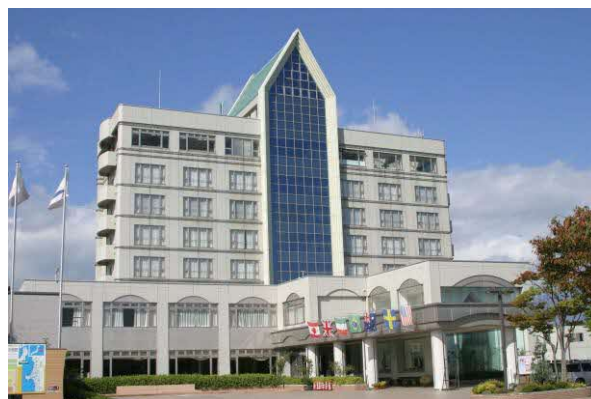
【ホテルサンルーラル大潟 外観】
