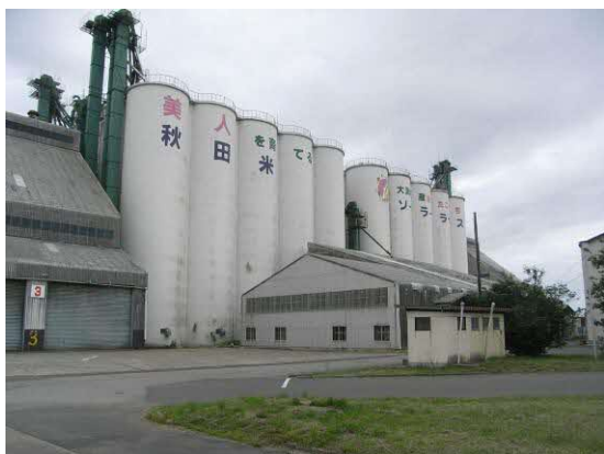
【大潟村カントリーエレベーター公社 外観】
