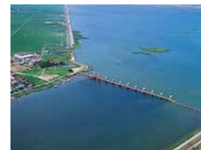
海水と淡水の境目、防潮水門 Tidal gate
