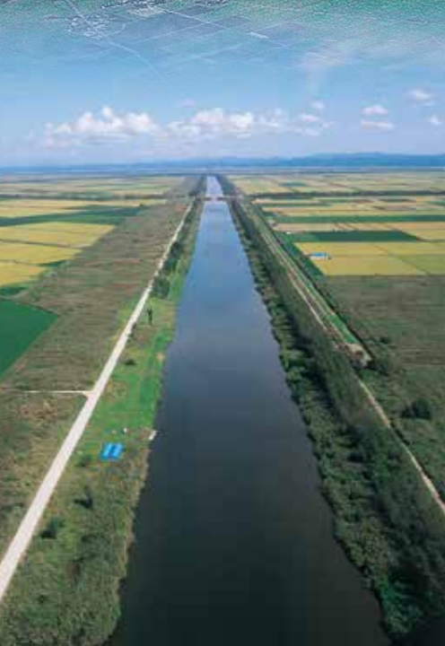
中央幹線排水路 Central drainage channel
