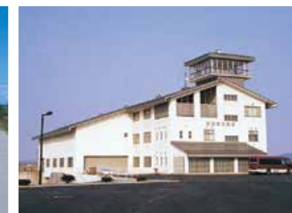
南部排水機場 South pumping station
