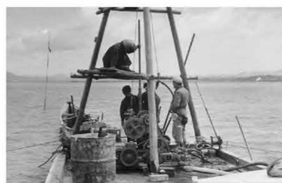
ボーリング調査
