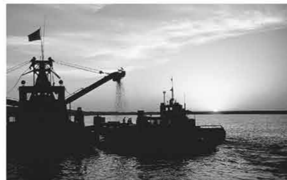
作業中の浚渫船
