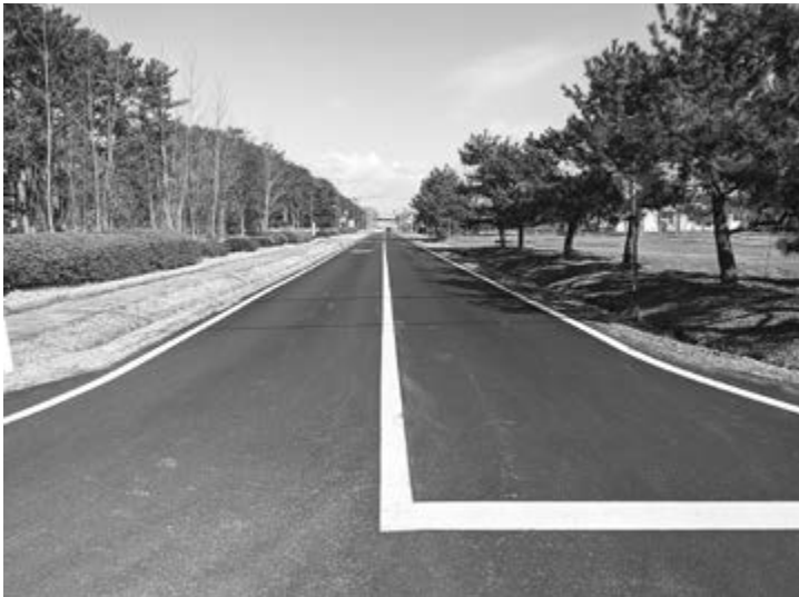
交付金を活用し行われた道路補修工事
