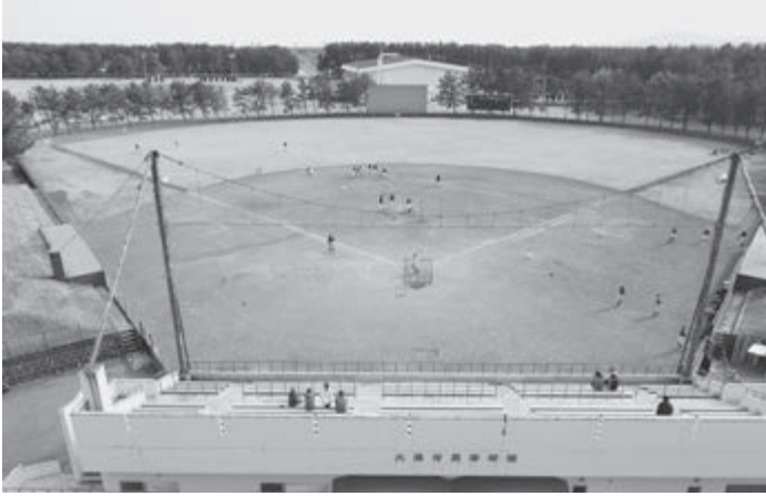
建設から40年以上経過した村民野球場
