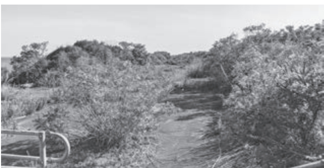
雑木・雑草の繁茂する堤防沿いの管理用道路
