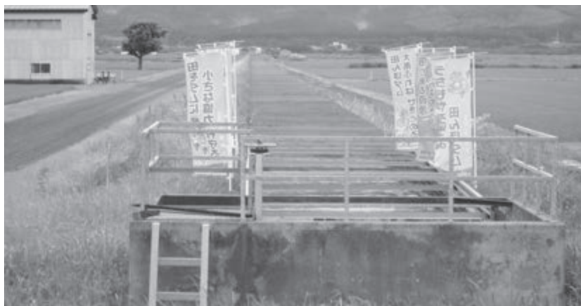
着工の目処がたった幹線水路の改修
