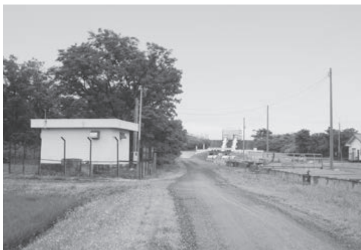
水源ボーリング調査予定地（正面堤防既存取水地）
