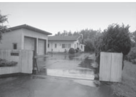
下水ポンプ場
