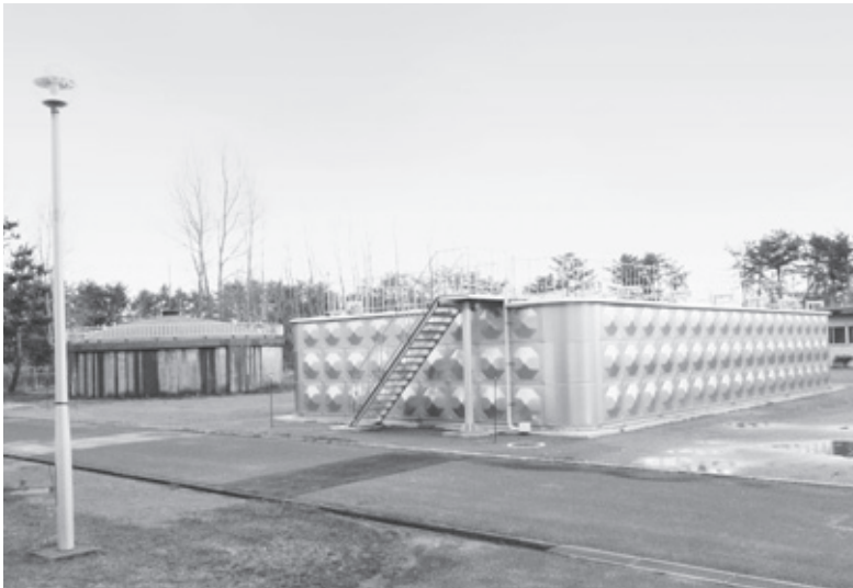
増設した配水池
