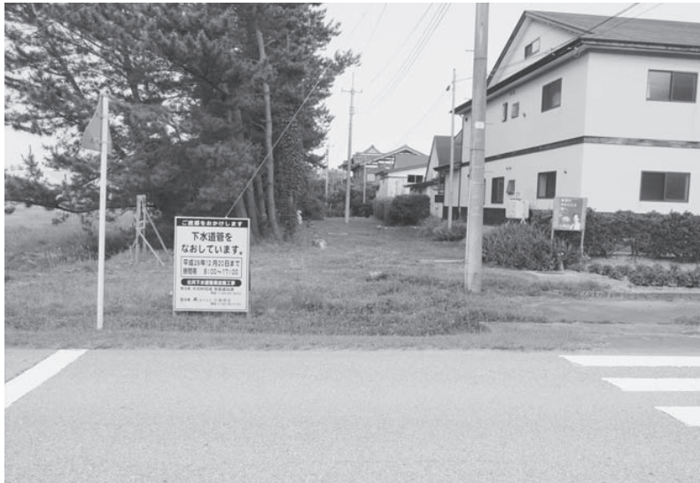
下水道管渠改築工事
