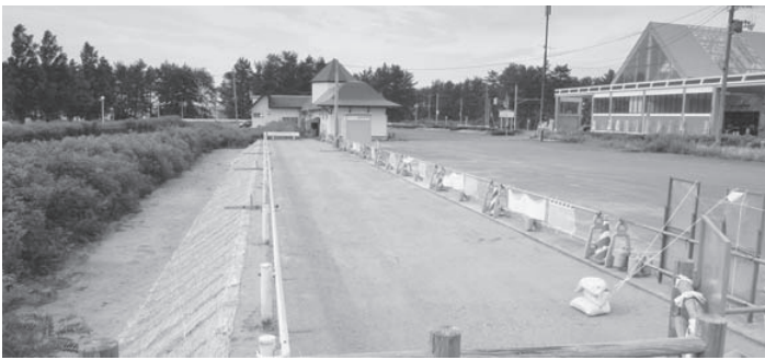
コンビニ建設予定地
