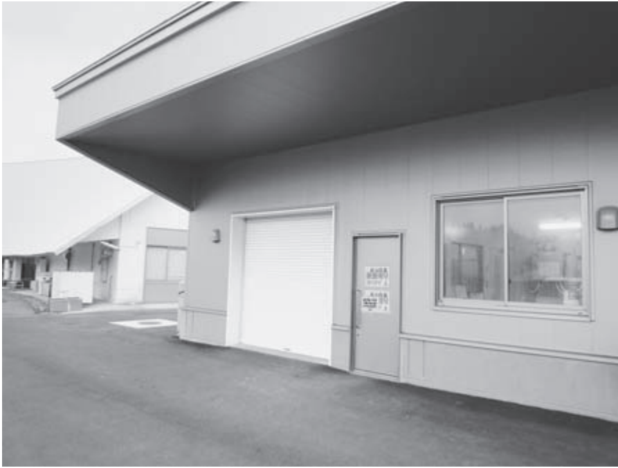
産直センター西側搬入口
