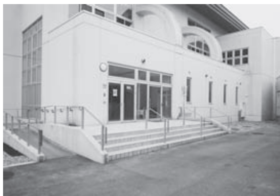
中学校体育館 西側出入り口
