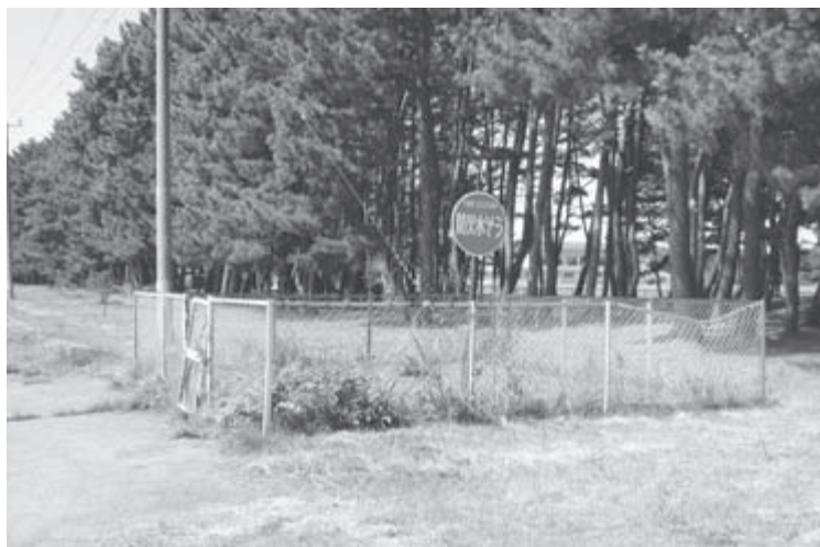
村内の防火水槽
