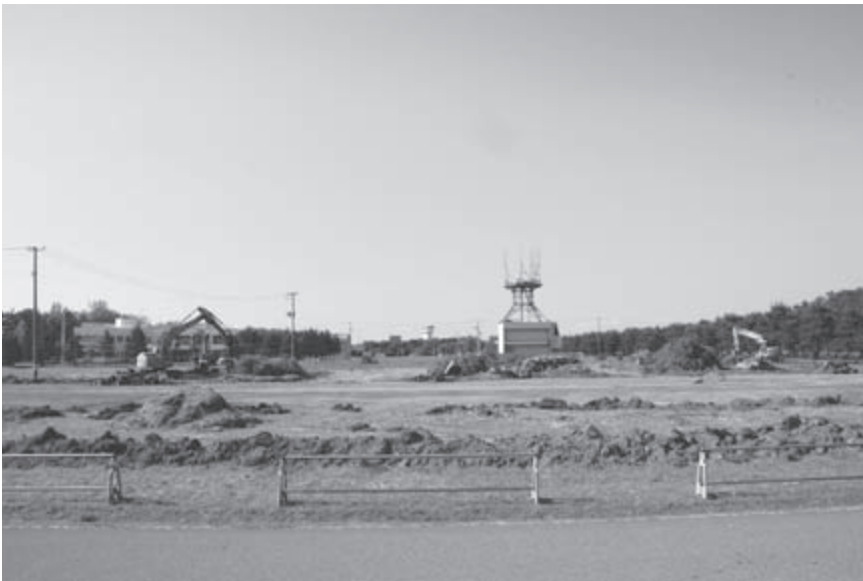
中央3番地内宅地造成工事
