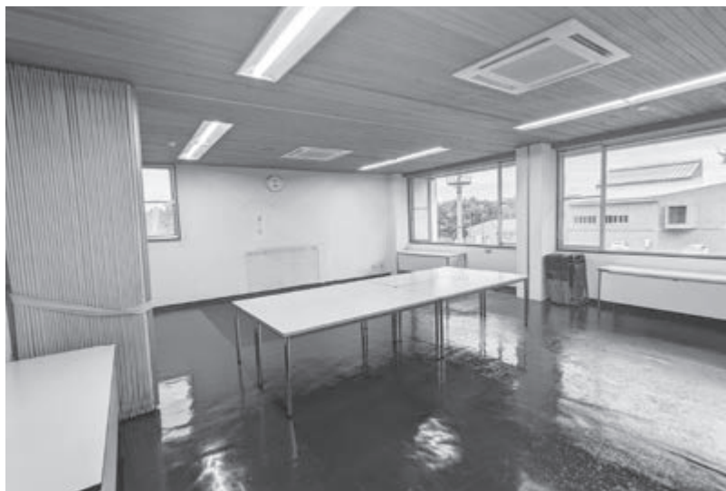
利用頻度の少ない公民館調理室を会議室に改修
